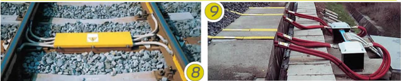
La figura 8 mostra la **traversa metallica** TMPC/SSE installata in prossimità del circuito TE, in corrispondenza delle casse induttive – risonanti delle S.S.E., con la fuoriuscita di tre cavi per parte di sez. 240mmq. allineati, compatti e bloccati da appositi fissa cavi. La figura 9 evidenzia la protezione dei cavi con cavidotti a partire dall'interno della **traversa metallica** fino alla connessione delle apparecchiature.
